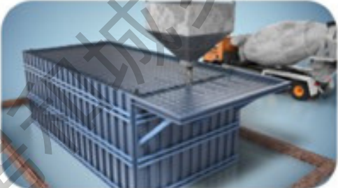
合上模板并浇筑混凝土
